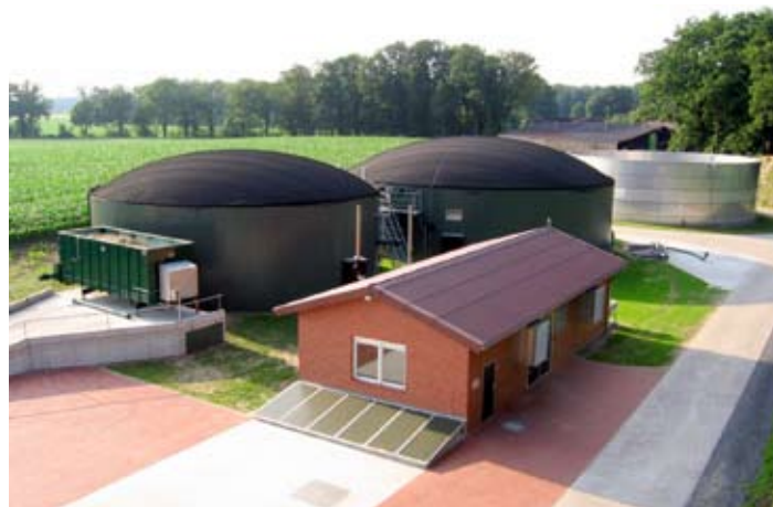
Celkový pohľad na bioplynovú stanicu
