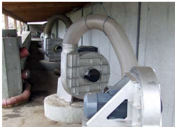
Vzduchotechnika na prevzdušňovanie kompostovacích základok
