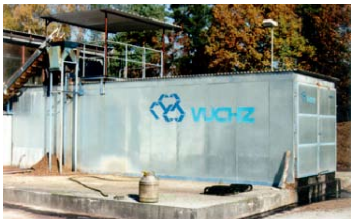
Kontinuálny fermentor zabezpečuje hygienizáciu a kompostovanie BRO
