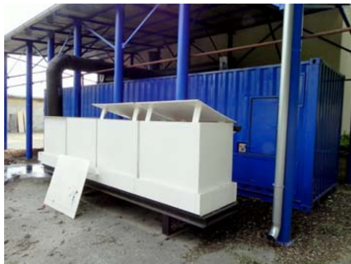
Biofilter na čistenie plynov vznikajúcich pri fermentácii vo fermentore EWA
